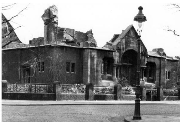
Zerstörte Synagoge in Herne Hermann-Löns-Straße
