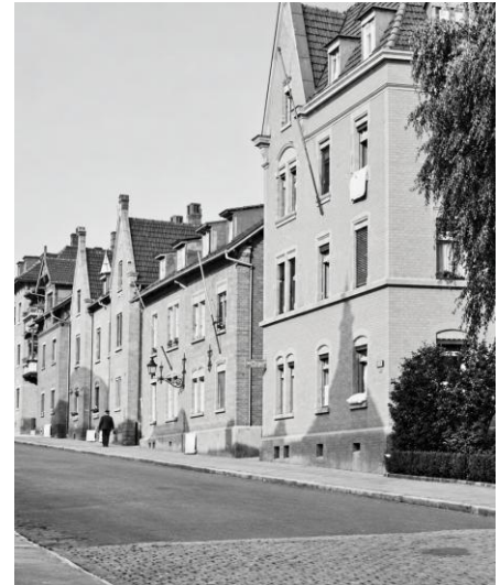
Stuttgart-Ostheim Arbeiterkolonie Strombergstraße
