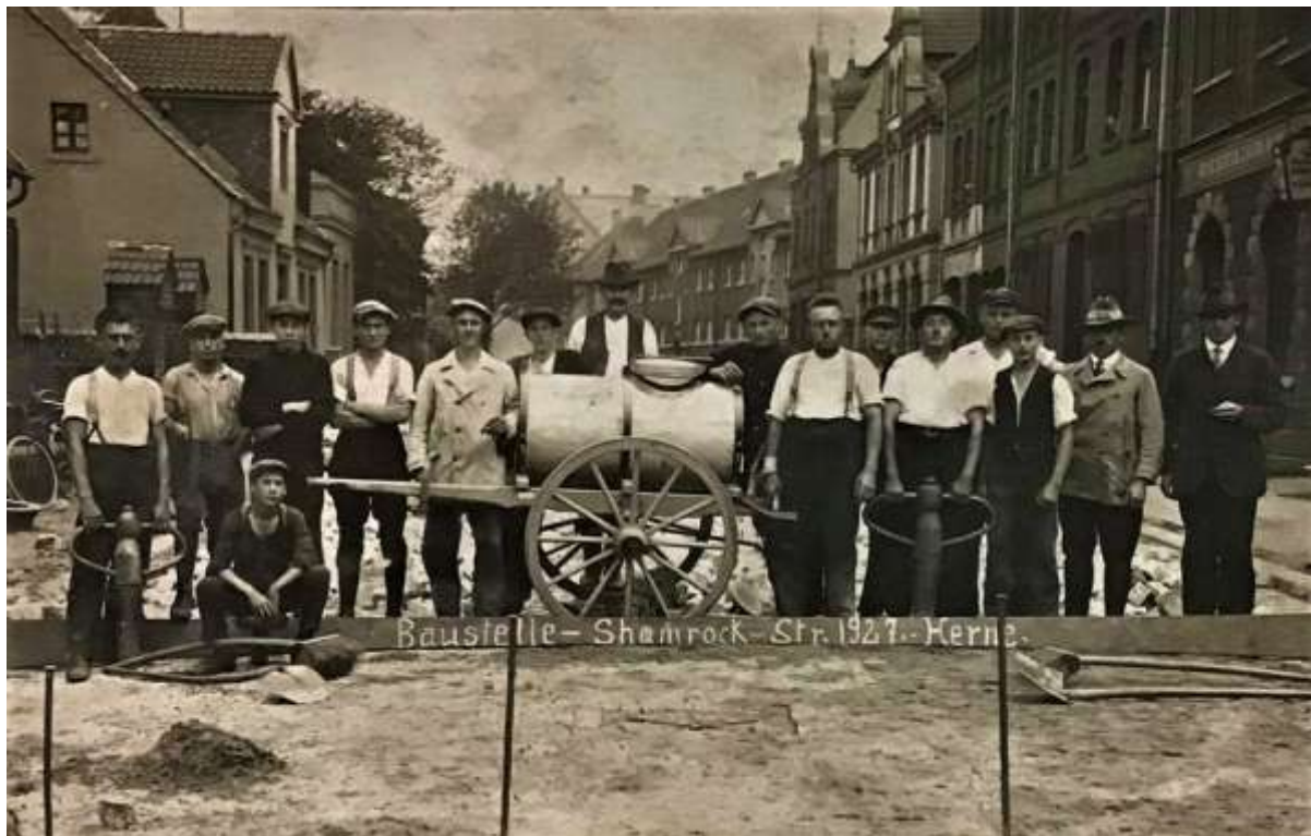
1927: Tiefbauarbeiter der Stadtverwaltung Herne an der Shamrockstraße
