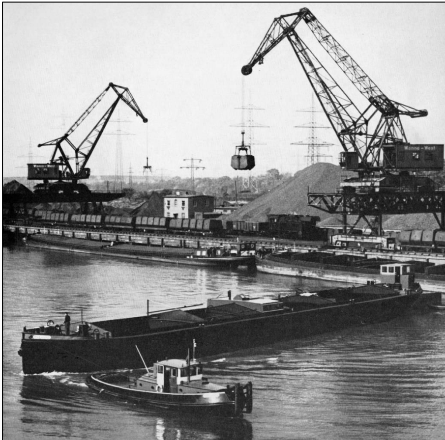
Abb. 4.62: Der Westhafen in Crange mit der Brücken- und Wippkran-Anlage genannt „Krummer Hund“, um 1950. Im Bildmittelgrund die Wanne-Bochum-Herner Eisenbahn bei der Entladung. Im Bildvordergrund das Motorgüter-schiff genannt „Rhein-Herne-Kanal-Kahn“ mit Schlepper bzw. Bugsierboot. (Quelle: KROME 1963, S. 25).
