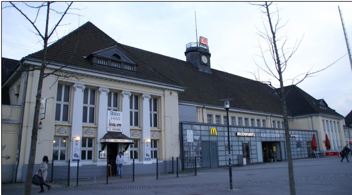
Abb. 4.17: Empfangsgebäude des Bahnhofes in Wanne-Eickel von 1913. Seit 1926 Wanne-Eickel Hauptbahnhof. (Quelle: EIGENE AUFNAHME 2014).
