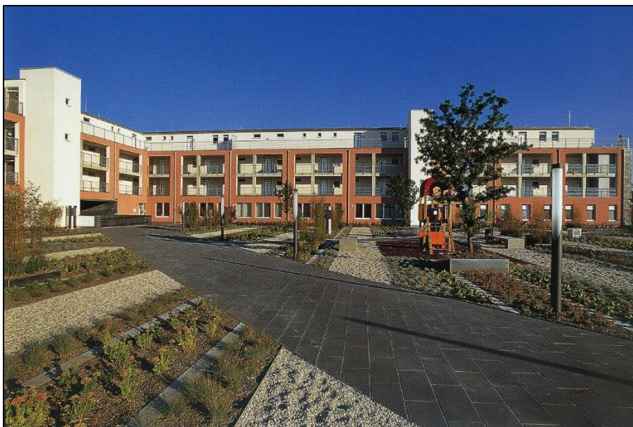
Abb. 4.109: Das begrünte Dachgeschoss des neuen Stadtteilzentrums Herne-Sodingen, 2005. (Quelle: HILDEBRANDT 2006, S. 29).
