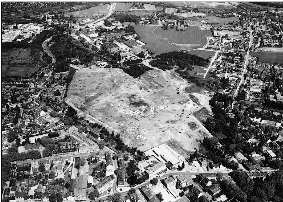
Abb. 4.82: Die Zechebrache Mont-Cenis, um 1984. Luftaufnahme, Blick Richtung Norden. (Quelle: OPEN IBA 2018).
