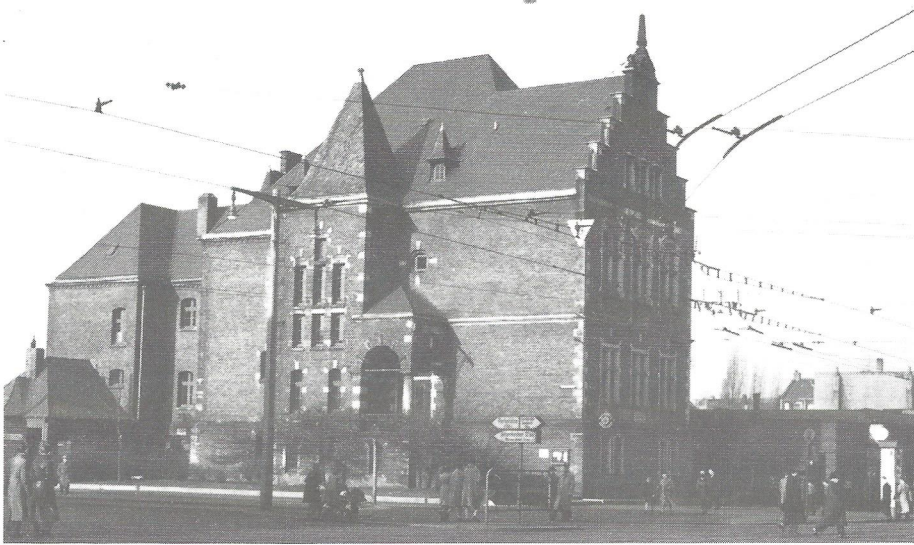
Das frühere Amtsgericht, in dem lange Zeit die städtische Bücherei untergebracht war. Während der Nazi-Zeit hatte die SA-Standarte dieses Gebäude beschlagnahmt.
