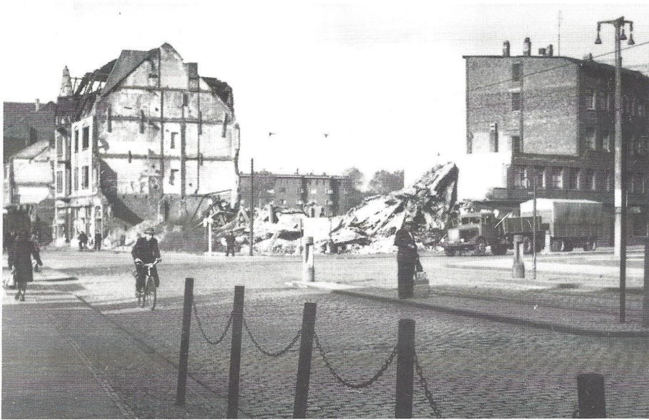
Am 9. April bot Wanne-Eickel den einrückenden alliierten Truppen das Bild eines vom totalen Krieg gezeichneten Gemeinwesens: 92 vorwiegend auf Industrie- und Verkehrsanlagen gerichtete Luftangriffe hatten 5.760 Gebäude vernichtet oder beschädigt, 41,6 v. H. des vorhandenen Wohnraums waren unbenutzbar, die Brücken waren gesprengt, der öffentliche Verkehr ruhte. Im Bild der Glückaufplatz.
