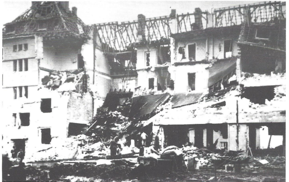
Herne, Bochumer Straße 125 - 131. Eine Minenbombe hat die Häuserzeile zerstört und dabei einen Menschen getötet.
