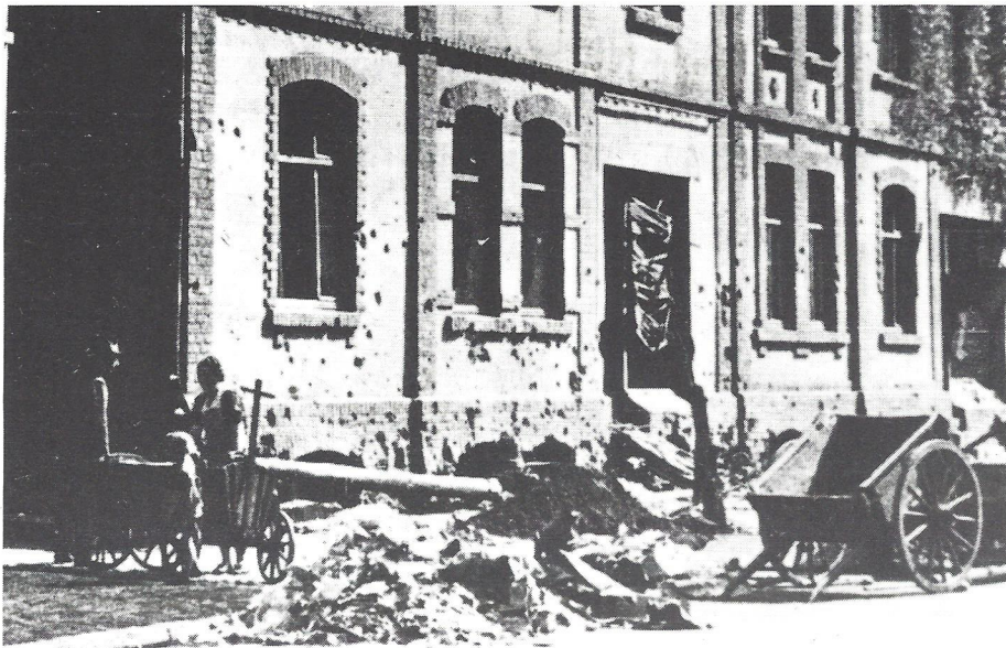
Bei der Beseitigung der Trümmer mußten alle mit anpacken. Die Handkarren waren die wichtigsten Transportmittel.
