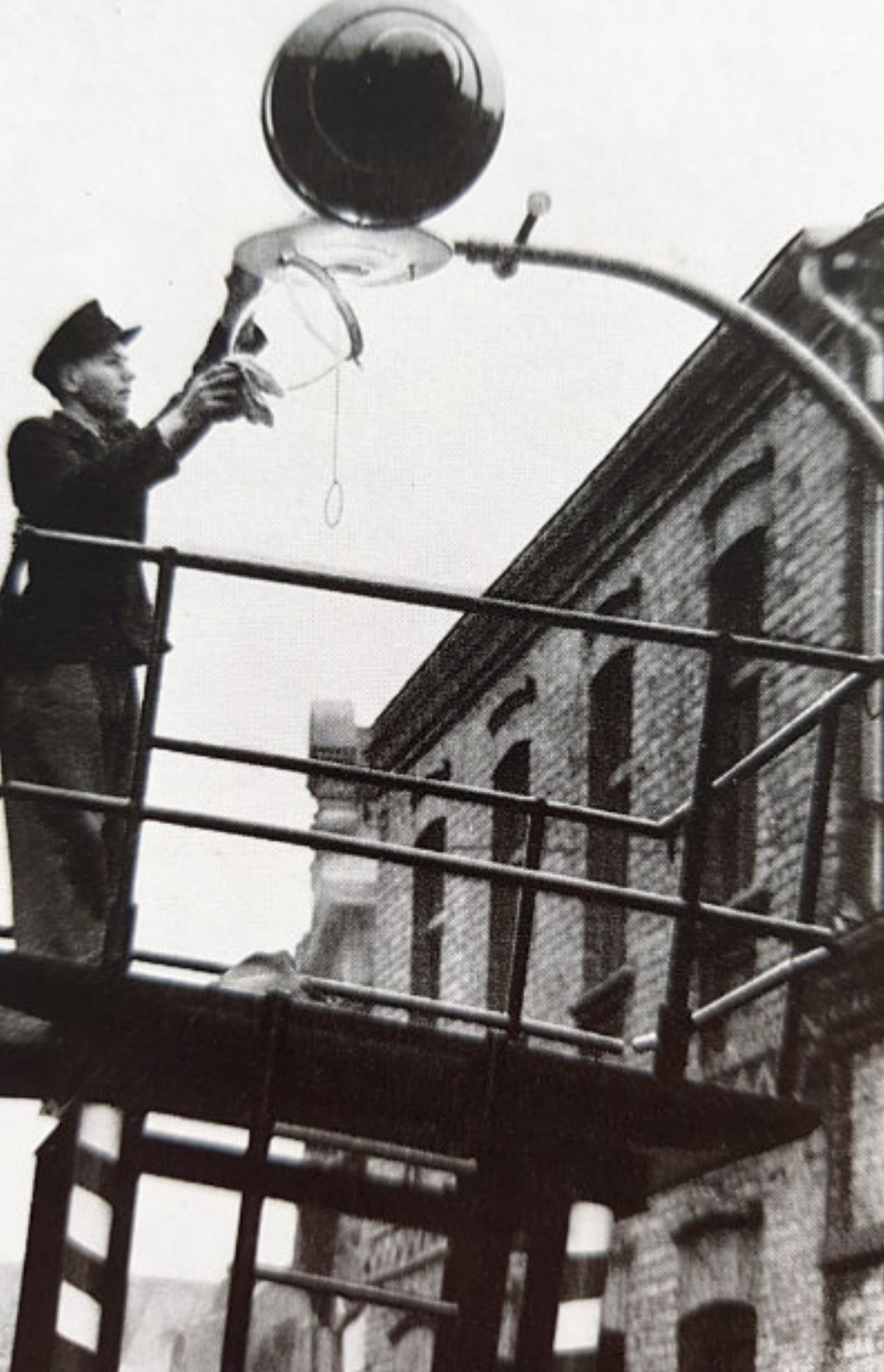
Ein Leuchtenwärter reinigt eine Gasleuchte mit einem Lappen vom Turmwagen aus.
