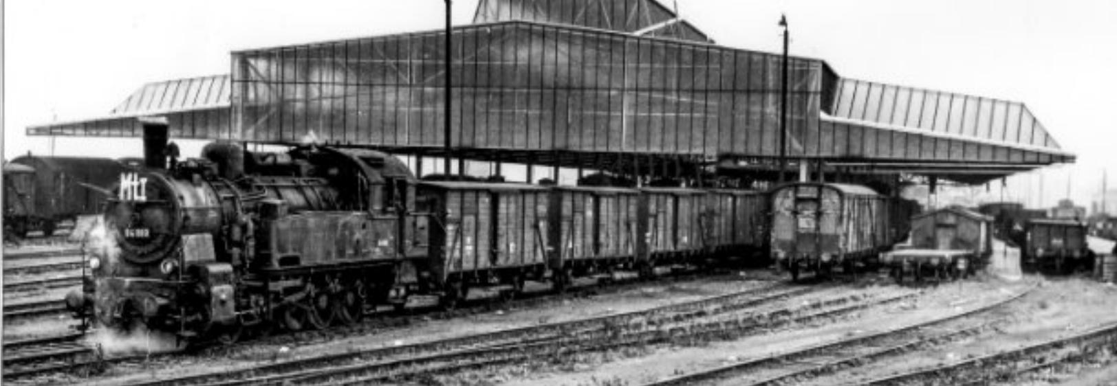
Blick auf die riesige Halle des Stückgut-Umladebahnhofs Wanne-Eickel Hbf. Eine Tenderlok der Baureihe 94, natürlich beheimatet beim Bahnbetriebswerk Wanne-Eickel Hbf, rangiert Stückgutwagen (gedeckte Güterwagen, abgekürzt »G-Wagen«). Sie trägt die Bezeichnung »Mt I«. So war der Gleisbereich der Umladehalle bezeichnet.
