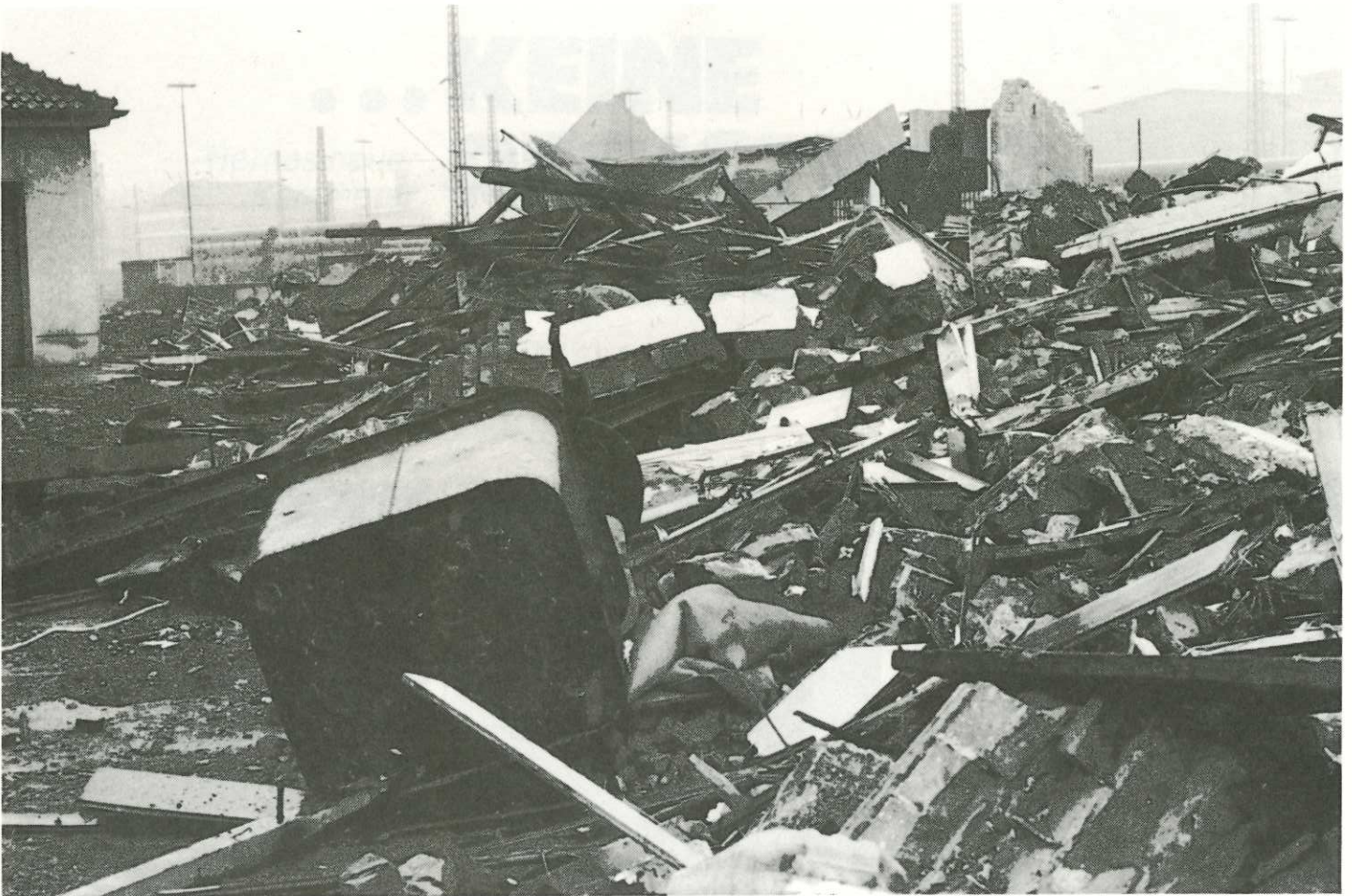
Die Bagger haben auf dem „Klöckner-Gelände“ bereits zugeschlagen.
