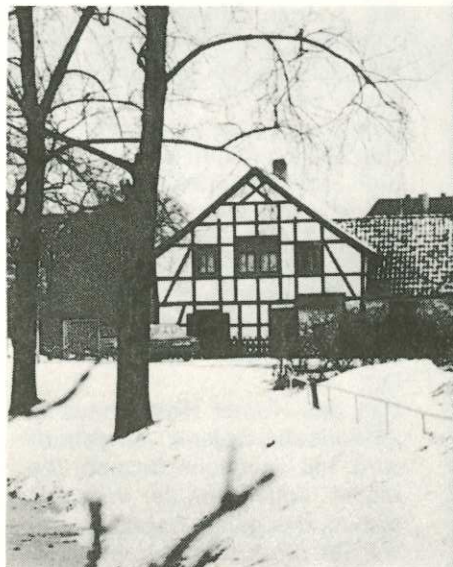
Baufällig — das Schollbrockhaus
