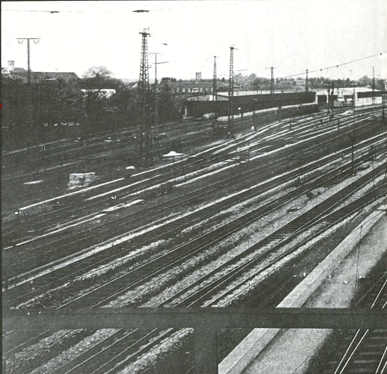
Blick vom neuen Stellwerk auf den Wannsee Hauptbahnhof
