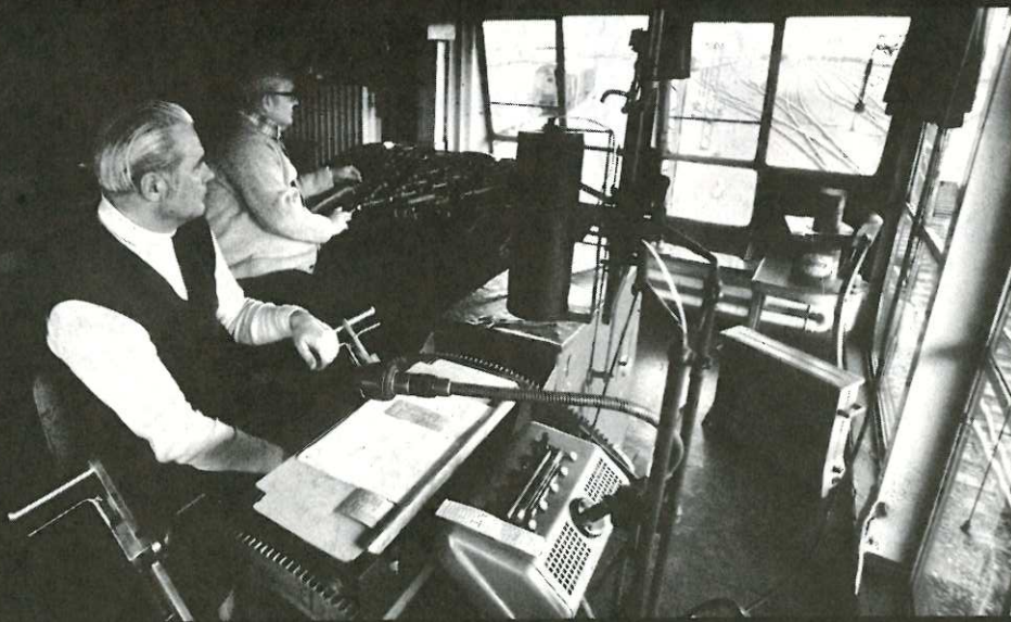
Stellwerk a la 1900
