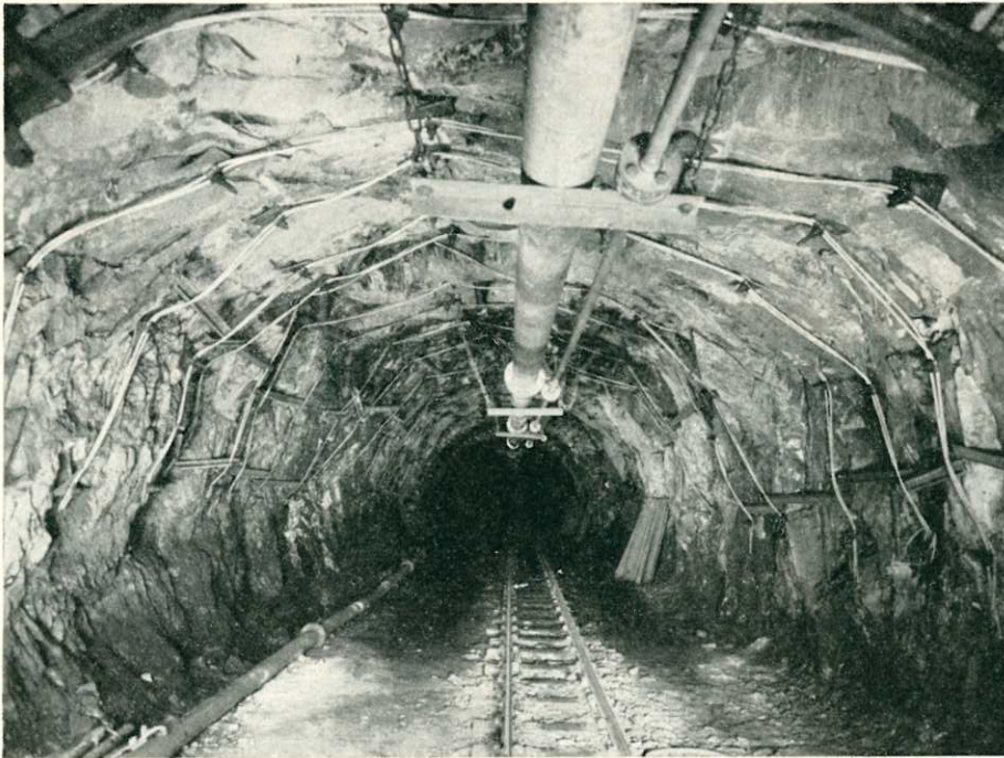
Ein Querschlag auf der 5. Sohle auf der Zeche „Recklinghausen II“. Da das Gestein sehr fest ist, wurde an dieser Stelle der sogenannte „Ankerabau“ angewandt.
