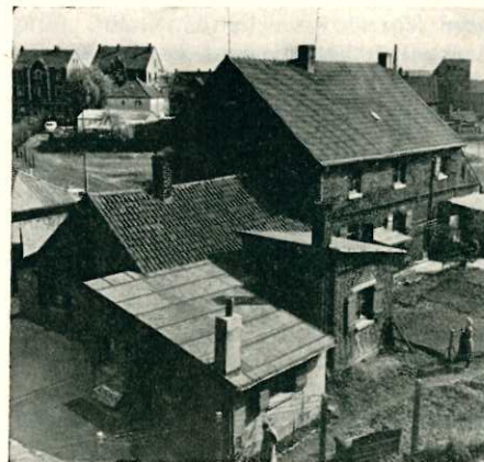
Die „Mostertmühle“ vom erhöhten STEAG-Gelände gesehen. Hintere Ansicht mit Anbauten. — Im linken Anbau war der Betrieb untergebracht.
