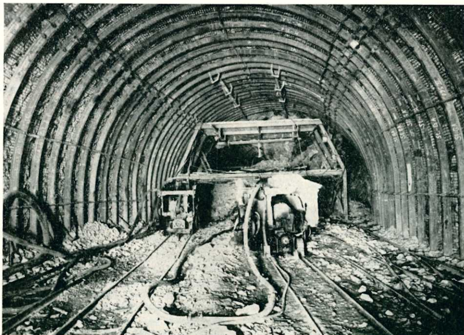
Neu aufgefahrene Querschläge haben meistens einen großen Querschnitt. — Die Auffahrung wird mit modernen Bohr- und Ladegeräten erleichtert und beschleunigt.
