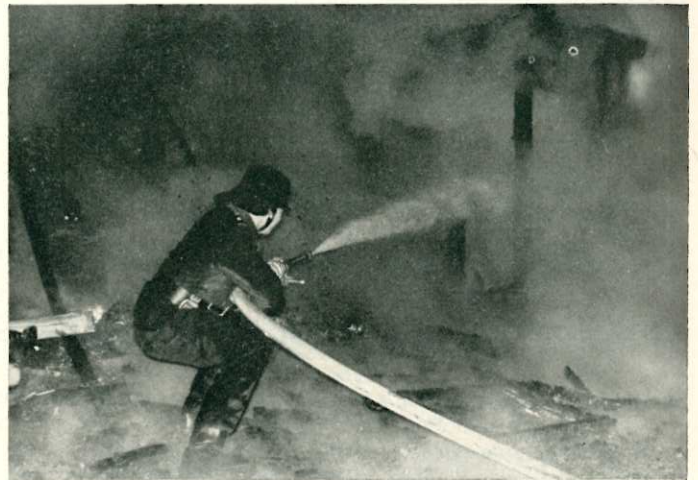
Einsatz der Feuerwehr an der Lützowstraße — Wasser marsch! (Bild: Willi Lütkehaus)
