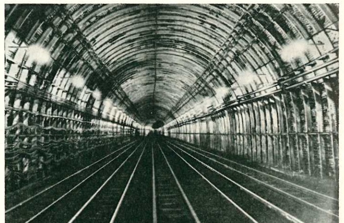
Füllort auf der 6. Sohle vom Schacht „Konrad Ende“ aus gesehen.
