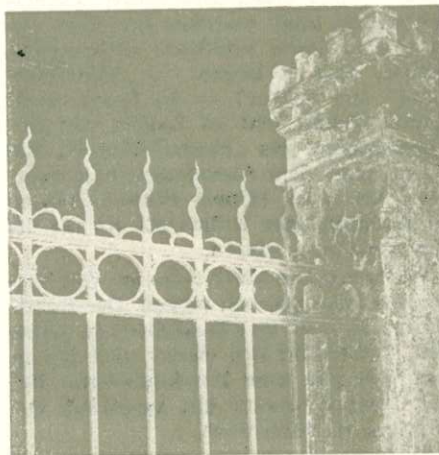
Teil des schmiedeeisernen Gitters am Baukauer Amtshaus.
