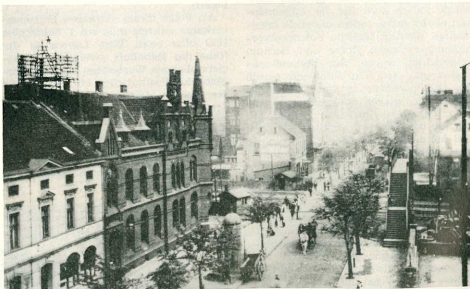
Der dunkle Eckbau links im Bild ist das von 1895 bis 1910 benutzte (zweite) Postamt an der Bahnhofstraße. Es schloß sich, wie auch erkennbar, an das damalige Bahnhofshotel, nachmals „Tante Anna“, heute „Wienerwald“ an. Auf dem Dach ist der Telegraphenkorb, das viereckige Gestänge mit der Vielzahl der Porzellanisolatoren für die hier an- und abgehenden Fernsprech- und Telegraphenleitungen zu erkennen. Sie führen von hier aus die Eisenbahnstrecke entlang. Heute liegt die Fabrikstraße auf der nördlichen und ein Teil des Bahndammes auf der südlichen Grundfläche des damaligen Gebäudes. Auf der Bahnhofstraße sind die Giebelfronten noch heute stehender Gebäude zu erkennen.
