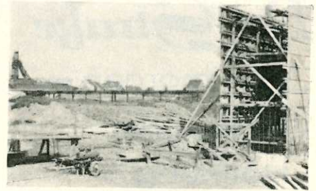
An der Stelle, an der früher die Roehenstraße die Verbindung zum Werkseingang der Hibernia darstellte, wird nunmehr eine Fußgängerbrücke über die neue Bundesstraße 51 errichtet. Über diese Brücke können dann die Betriebsangehörigen, die ihre Fahrzeuge auf einem einzurichtenden Parkplatz östlich der neuen Bundesstraße 51 stehen lassen, ihren Werkseingang erreichen. Rechts die Einschalung für das Widerlager dieser Fußgängerbrücke.
