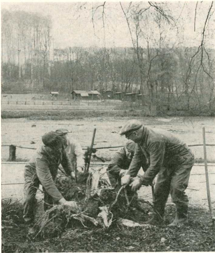
Rodearbeiten im Bereich des Tierparks am Gysenberg. — Der trockengelegte Teich wird entschlammt. Hier wird man im Sommer kahn können.
