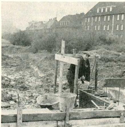
Die Grünanlage am Hölkeskampring/Ecke Wiescherstraße erhielt im Übergang zum tieferen Gelände eine Rampe mit Stützmauern. — Treppen werden vermieden, um Kinderwagen und „Kinderautos“ einen ebenen Weg zu bieten.
