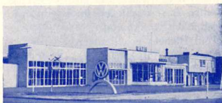
Klar von zweckbetonter Schlichtheit ist der Baustil der Betriebsgebäude an der Bochumer Straße.
