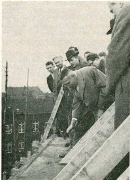
Richtfest zum Erweiterungsbau am 15. Januar 1958.
